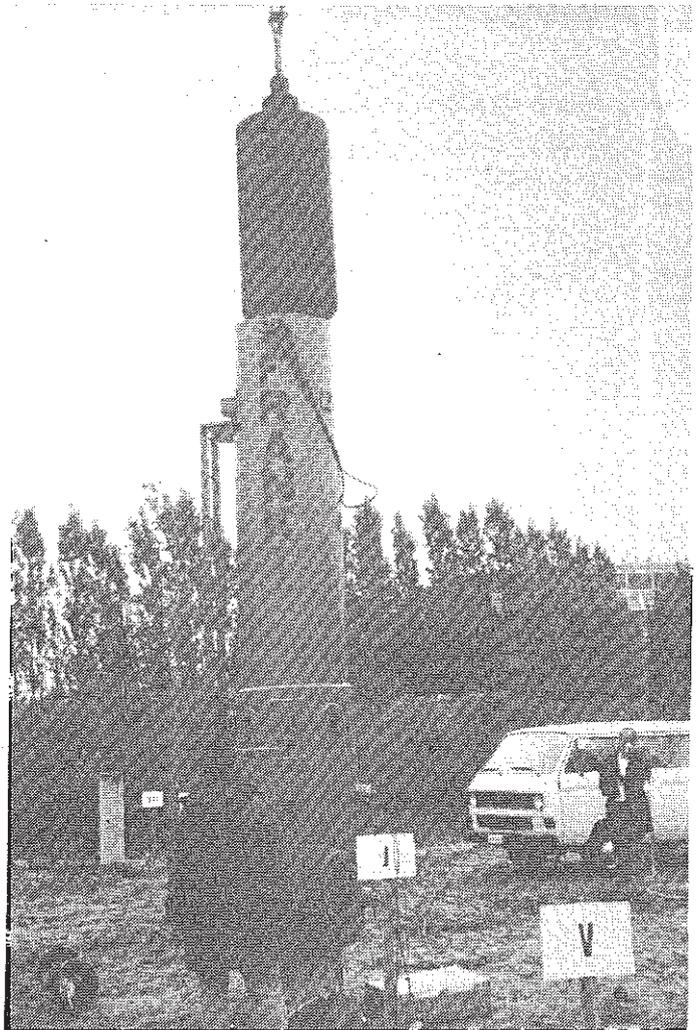
corollairement d'induire l'enfoncement transitoire du pieu le plus grand possible) et l'impératif de ne pas casser le fût du pieu. Le système complet est mis en place sur la tête du pieu après placement de l'instrumentation.
